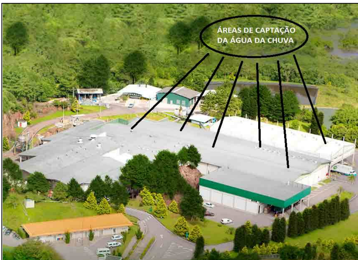
Figura 9 - Vista Aérea dos Telhados da Vapza
